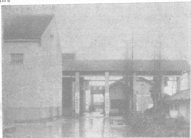
△嵒厦棉花收购站
