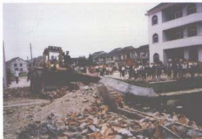
▶ 拆除非法占地建筑物现场
